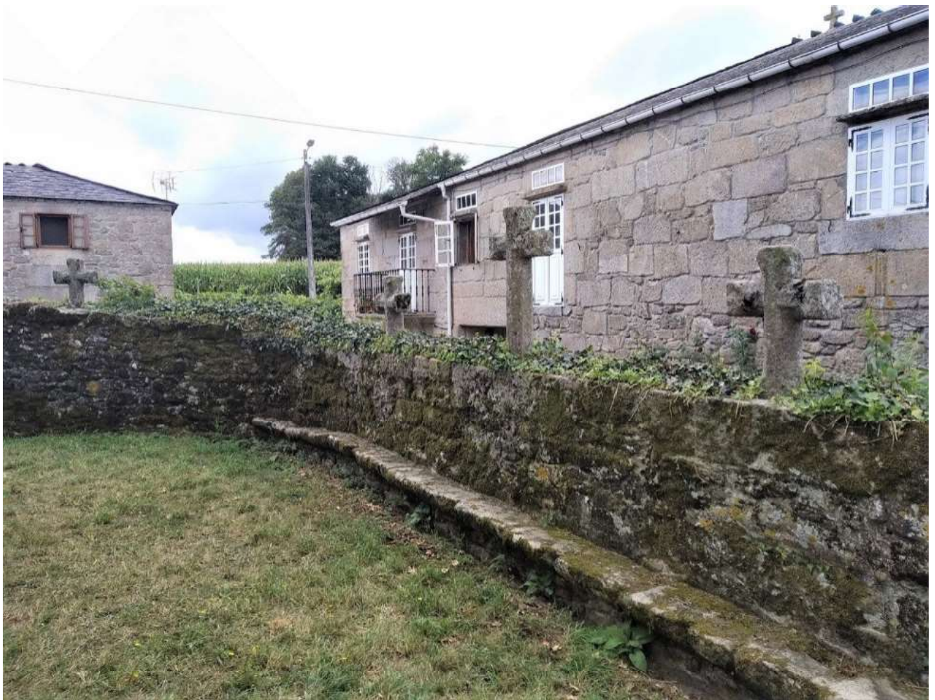
FOTO N° 11. RESTOS DO VIACRUCIS ( MURO)
